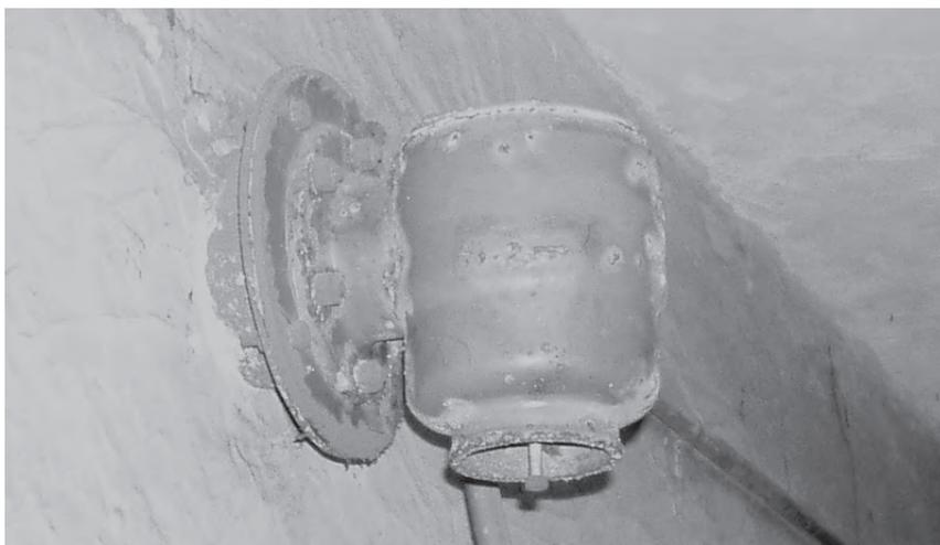
*Immagine n.20 - Una delle due speciali valvole, applicate sulle condotte di scarico dell'aria. Il loro funzionamento era basato di un semplice sistema a peso: raggiunto il valore di pressione interna prestabilito, le valvole si sarebbero aperte, lasciando defluire l'aria in eccesso.*
