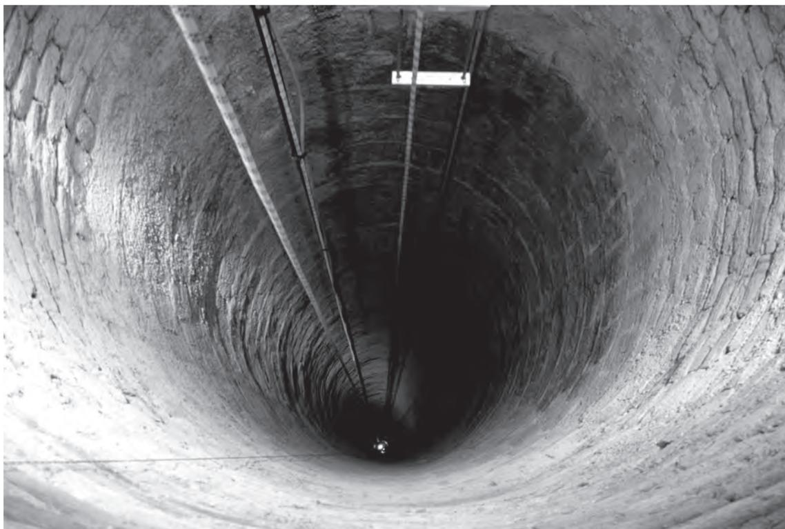
*Pozzo di Moncrivello - Vercelli. Esplorazione e rilievo del pozzo profondo 85,48 metri. (foto Basilico R.)*
