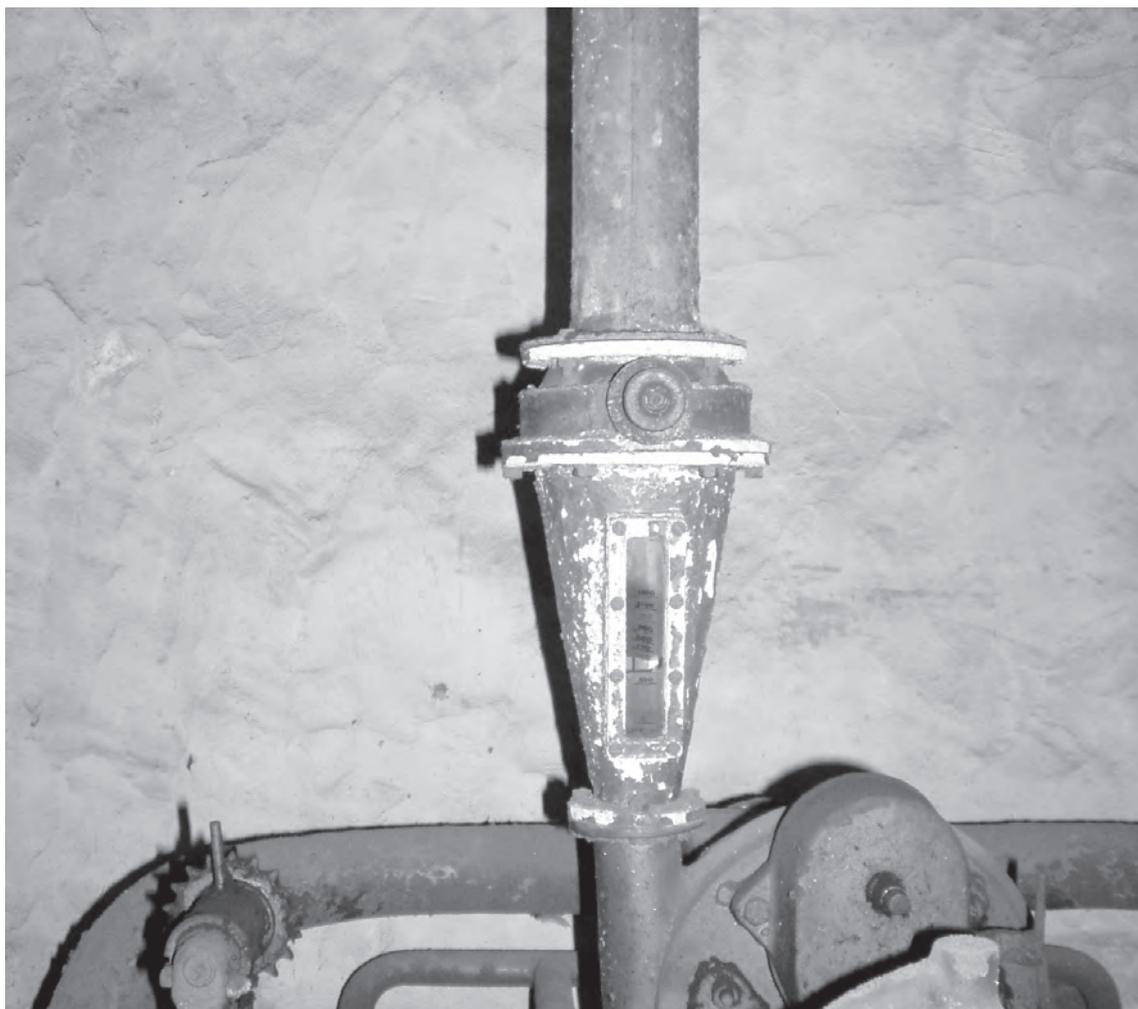
*Immagine n. 19 - Flussimetro a cono. Sulla parte trasparente è riportata la scala graduata a misurazione del passaggio del flusso d'aria.*
